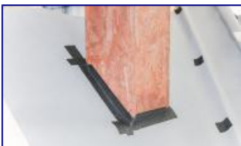
10. Готовая конструкция у печной трубы.
