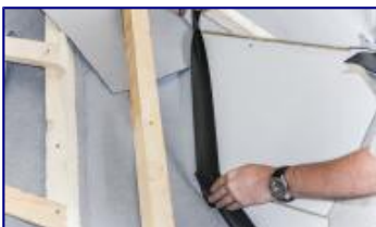
4. Наклеивать ленту в углах внахлест сверху вниз с запасом 4 см.
