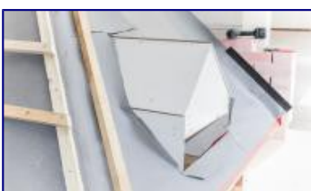
1. Обрезать края мембраны по периметру слухового окна, обеспечив нахлест 4 см.
