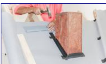
11. Начать монтаж водоотводящей планки.
