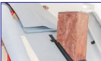
12. Монтировать на планку мембрану внахлест сверху вниз.
