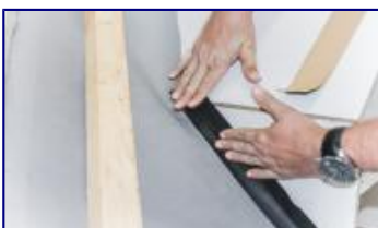
3. Герметизировать примыкания односторонней лентой для мембран М-1.
