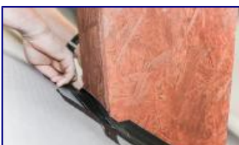
8. Монтаж ленты у верхней горизонтальной плоскости.
