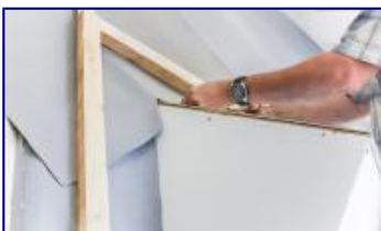
2. Монтаж мембраны в верхней части окна.
