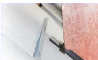
13. Герметизировать все стыки и примыкания лентой.
