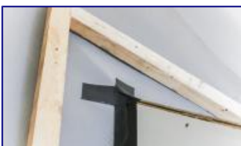
5. Перехлест лент в верхней части окна.
