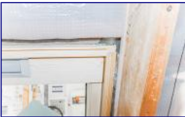
2. Аккуратно срезать по периметру рамы мансардного окна.
