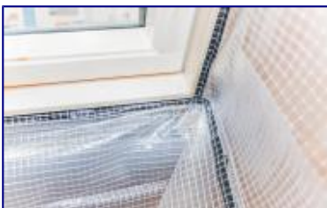
5. Герметизация нижнего угла.
