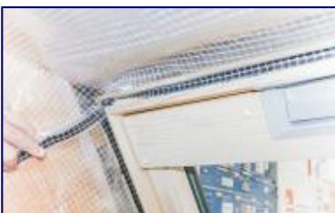
4. Герметизация внешнего угла.
